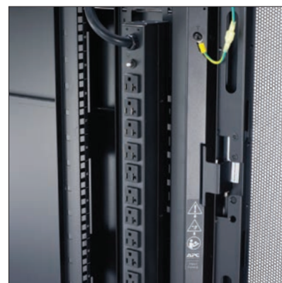
工具無しで取り付けしたラックマウントPDU
